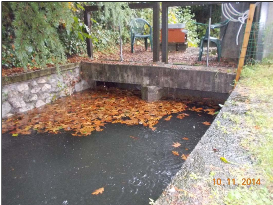
Foto 1: dettaglio chiusura paratie Acquanegra
